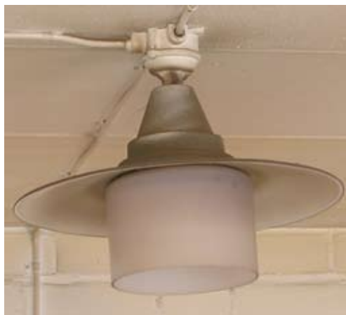
ASEA gjutjärnsarmatur med koniskt lamphus, emaljskärm och cylindrisk glaskärm, 1930–1940-tal.
